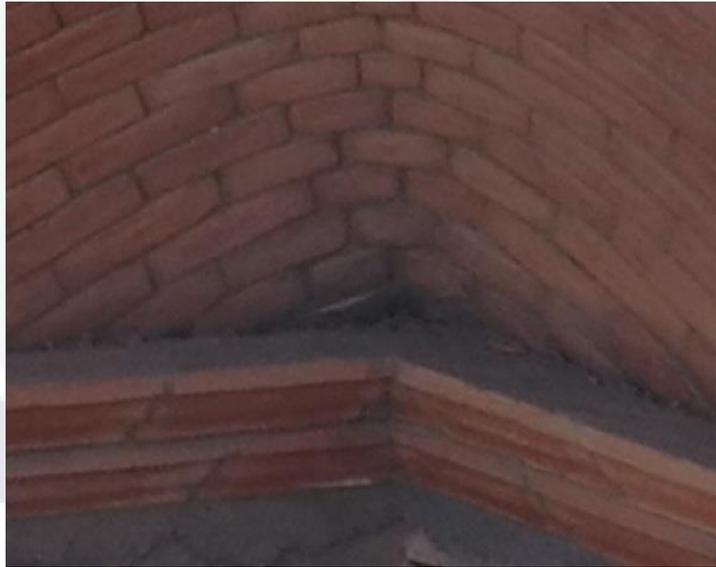
Figura 48. Detalle esquina, arranque de bóveda.
