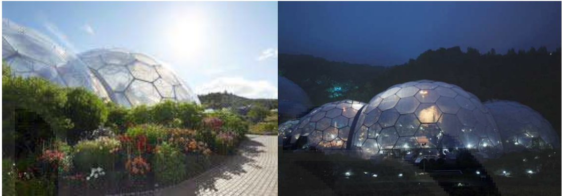
Figura 14: Cubierta en el proyecto Edén en Reino Unido, tanto en iluminación natural como nocturna
