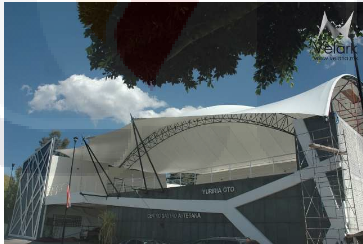
Figura 16: Cubierta soportada por arcos
