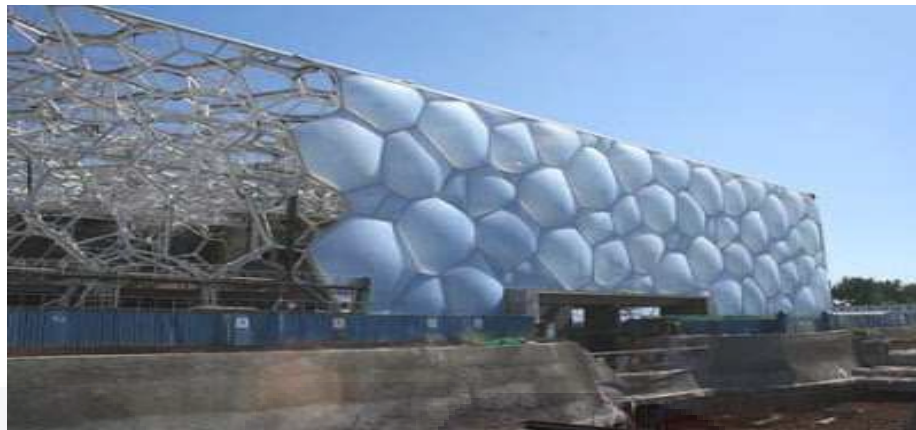
Figura 82: Lámina ETFE instalada en sistema multicapa a base de cojines presurizados en el centro acuático nacional de Beijing-China
