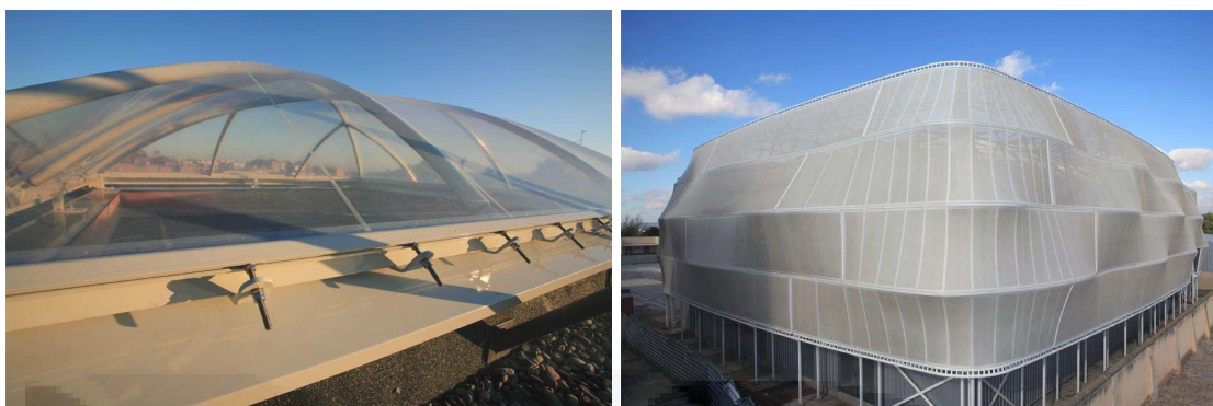
Figura 12: Cubiertas a partir de ETFE y PTFE respectivamente
