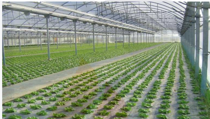
Figura 24: Cubierta y estructura para un invernadero
