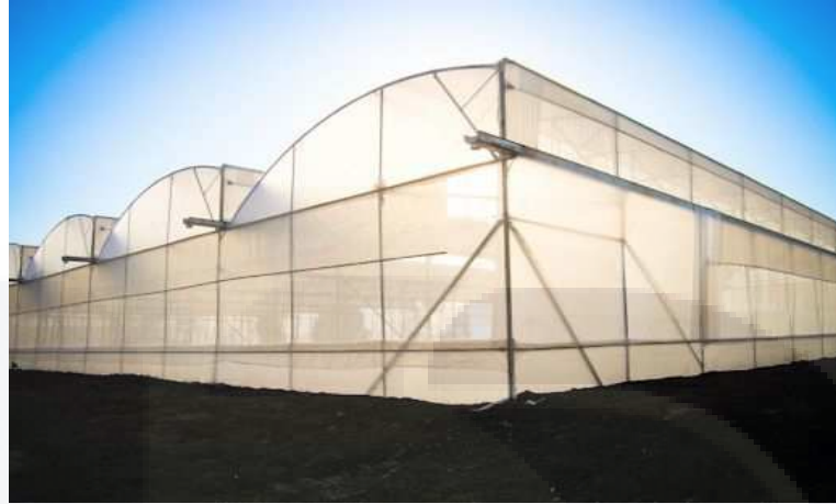
Figura 96: Invernadero tipo diente de sierra
