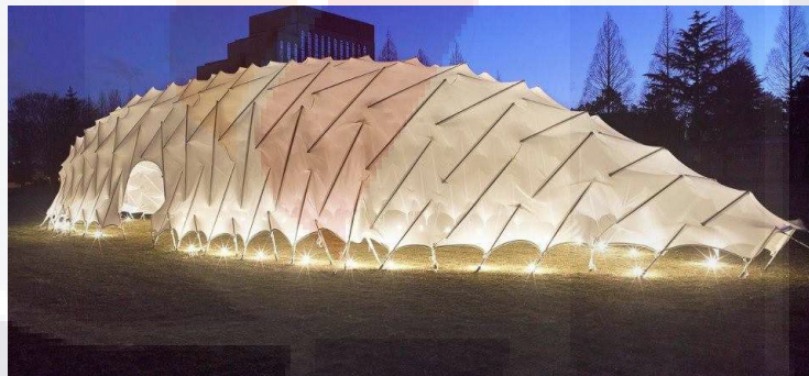
Figura 8: Cubierta a base del principio de tensegridad
