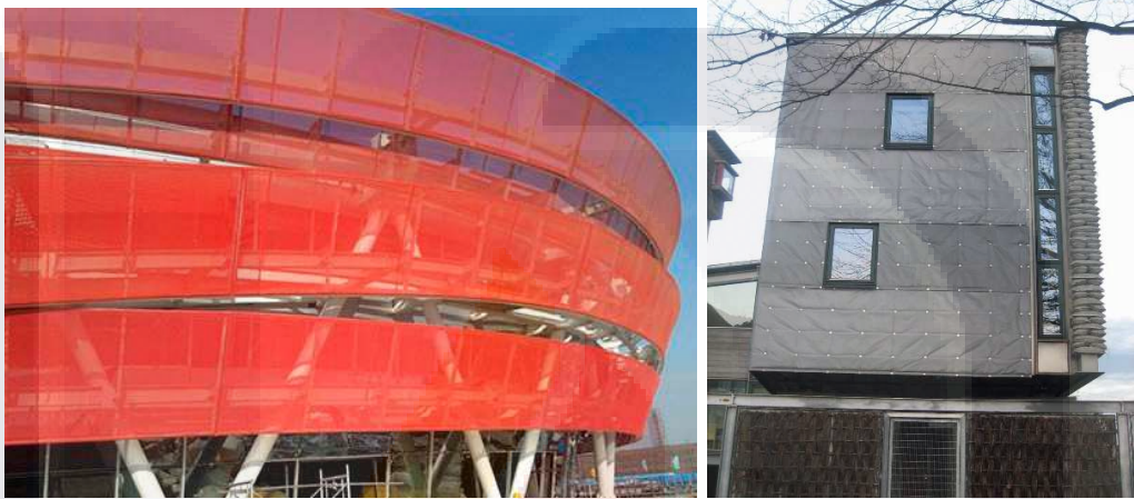
Figura 11: Membrana a partir de fibra de vidrio
