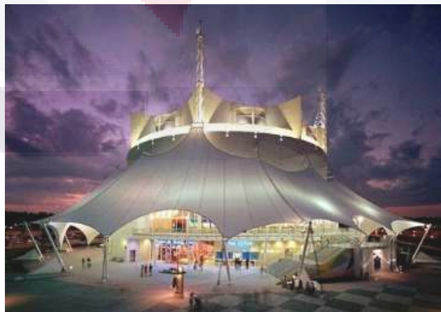
Figura 2: Ejemplo de una tensoestructura
