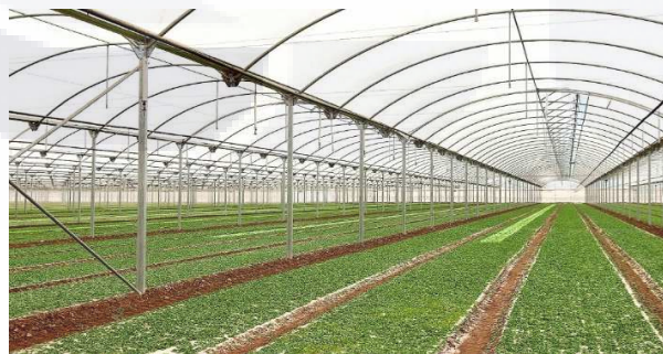
Figura 60 Invernadero tipo capilla, la cual es la forma más semejante a un arco
