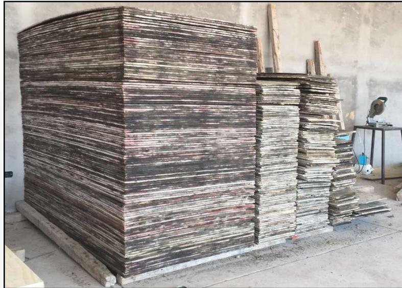
Figura 24. *Triplay* con aceite quemado empleado como agente desmoldante, resguardado para futuro re-úso.
