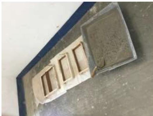
Figura 6 Moldes de madera utilizados como cimbra. A un lado aparece la mezcla de concreto previa al colado de las piezas.
