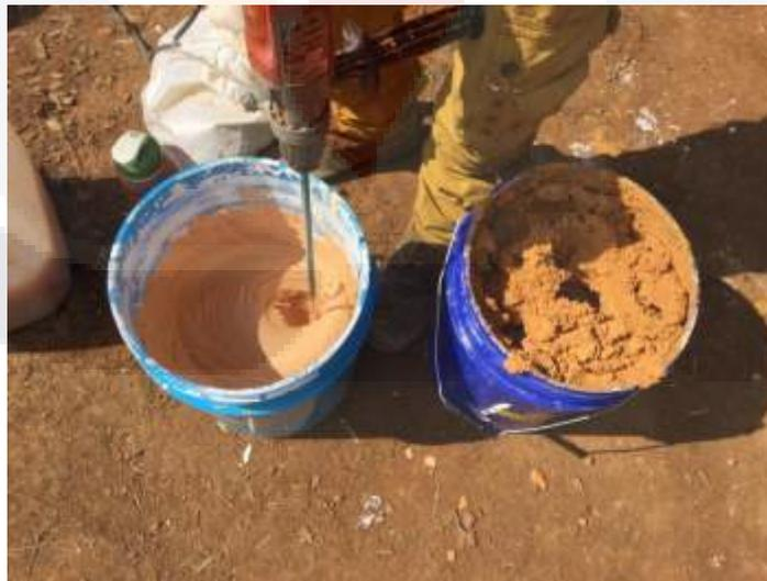
Figura 2 Mezclas para aplicar tadelakt adaptado a México. La que aparece del lado derecho, elaborada con cal hidratada de bulto, correspondería a la primera capa. A la izquierda, la mezcla hecha con cal hidratada en pasta se aplicaría para la segunda capa.
