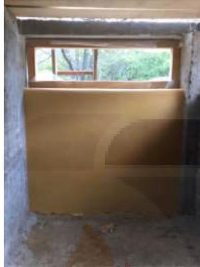
Figura 4 Apariencia de muro recubierto con tadelakt después de haberse aplicado y pulido la solución de jabón.
