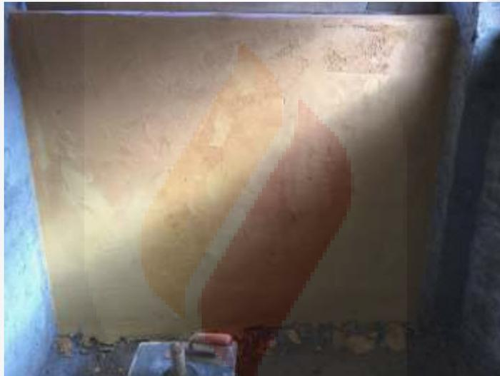
Figura 3 Primera capa de tadelakt aplicada sobre muro por maestro de construcción natural, previa a ser trabajada con la flota de madera (fotografía propia del autor).
