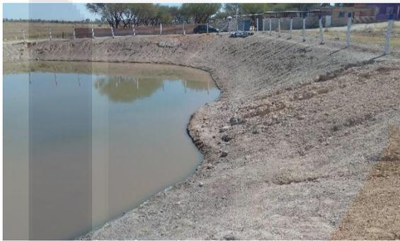
Figura 7 Talud deteriorado.
