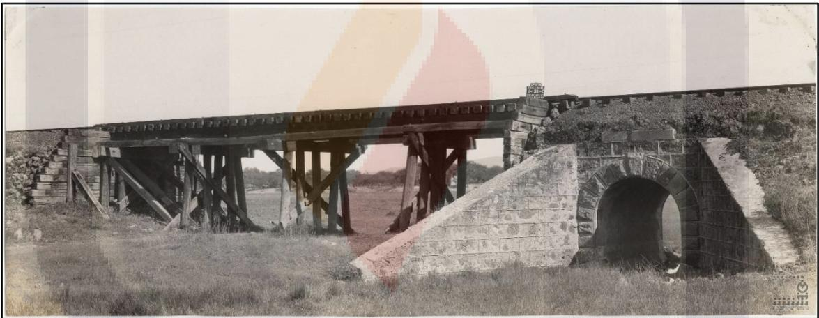
**Ilustración 19: Puente de 4 claros, traveses de madera, en bancos falsos, y alcantarilla de mampostería, bóveda semicircular una invertida, con aleros, claro 2.00.
