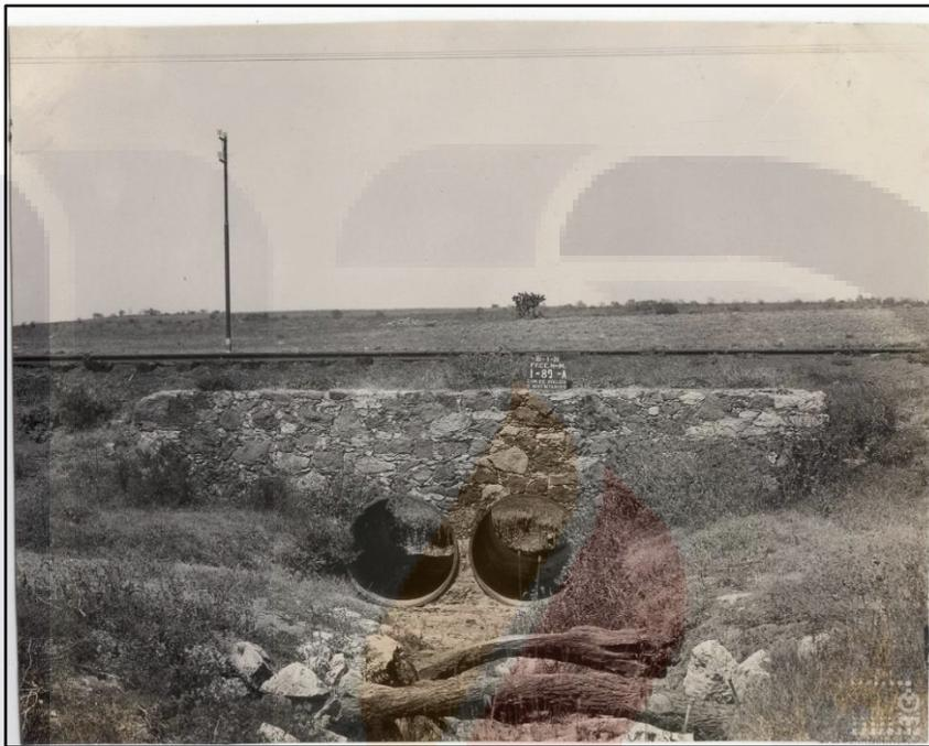
**Ilustración 22: Alcantarilla mampostería con 2 tubos de hierro de 1.21 de diámetro, sin aleros.
