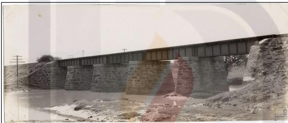
**Ilustración 26: Puente 5 claros, paso superior, traves compuesto, lamina remachada, 1 en cada lado, sobre machones y estribos de mampostería, en el rio Turbio.
