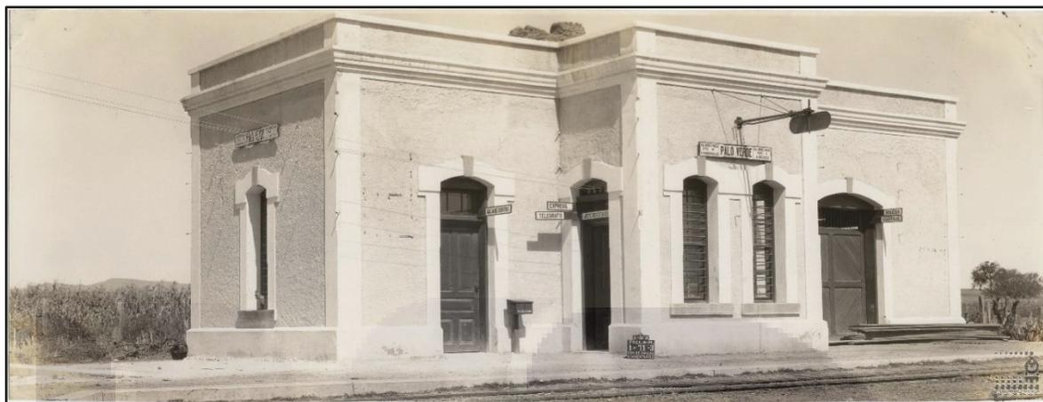
**Ilustración 20: Frente y lado norte del edificio, mampostería y bóveda, para oficinas de estación y bodega de carga. Palo Verde.**
