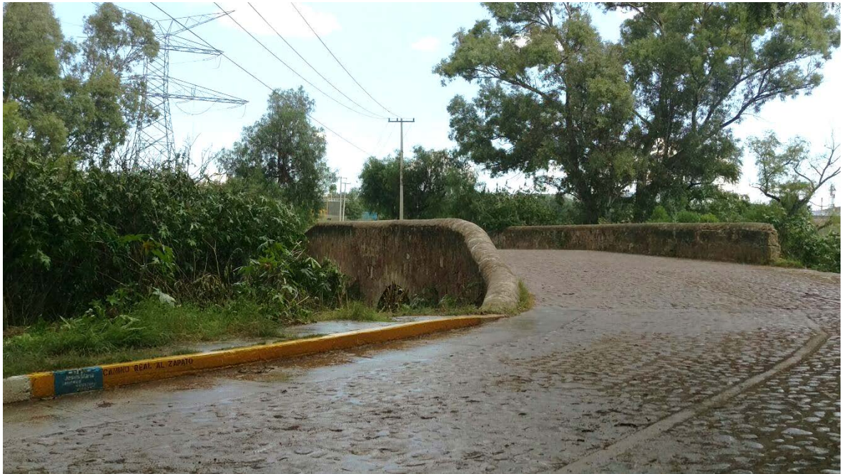
Imagen 31.- Fotografías de la estructura visual del área a planear. Fuente: elaboración propia en base a la galería fotográfica de VERTIQAL.
