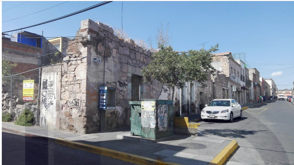
Fig. 1.- Inmueble derrumbado en la esquina de las calles Vicente Santa María y Mariano Elizaga. Al costado izquierdo construcciones de fábrica reciente sin relación con el contexto histórico, a la derecha, por la calle Vicente Santa María, perfil urbano irregular. Fuente: Carlos Pedraza Gómez. Enero 2017
