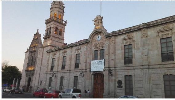
Fig. 41.- fachada del conjunto conventual dieguino, actualmente Facultad de Derecho de la UMSNH. Al costado el Santuario de Guadalupe. Fuente: Carlos Pedraza Gómez. Enero 2017
