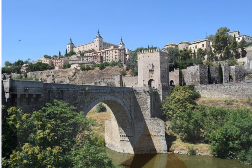
Fig. 3.- Puente de acceso de Toledo, España, constituido para la sociedad como ejemplo de adaptación del humano en el espacio, hito cultural con una fuerte carga simbólica no solo para la región sino para el país en general. Fuente: Carlos Pedraza Gómez. Junio 2015
