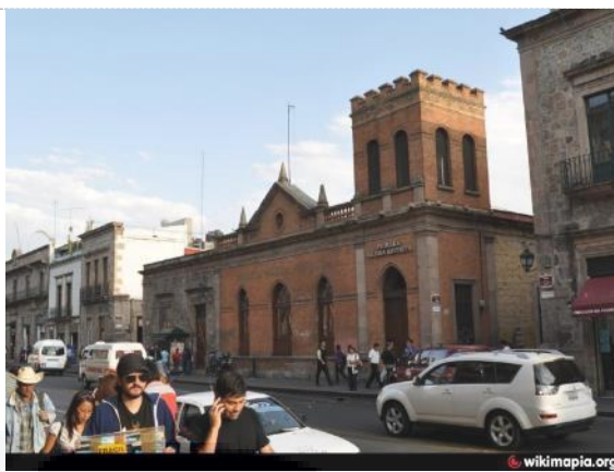
Fig. 35.- Primera Iglesia Bautista integrándose a la altura de las construcciones de la zona pero siendo distinta en estilo y materiales. Fuente de imagen: http://photos.wikimapia.org/p/00/03/62/29/79_big.jpg fecha consulta: 7 de enero de 2017
