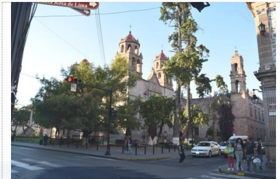
Fig. 29.-Espacio Abierto exterior de la Biblioteca pública municipal. Vegetación importante en la visual. Fuente: Carlos Pedraza Gómez. Enero 2017
