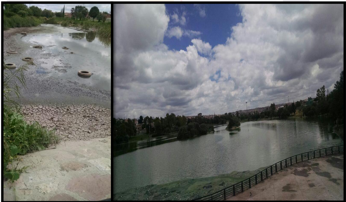
Fotografía 15. Presa de Los Gringos.
