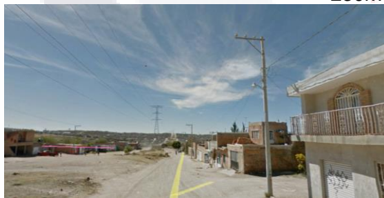
Fotografía 51. Líneas de tensión, 230kv aérea.
