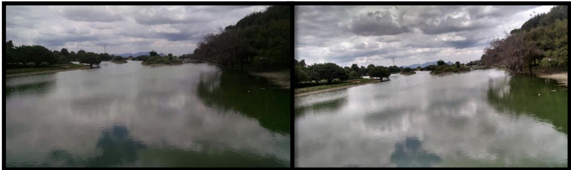
Fotografía 2. Vista desde la cortina, Presa de Los Gringos.
