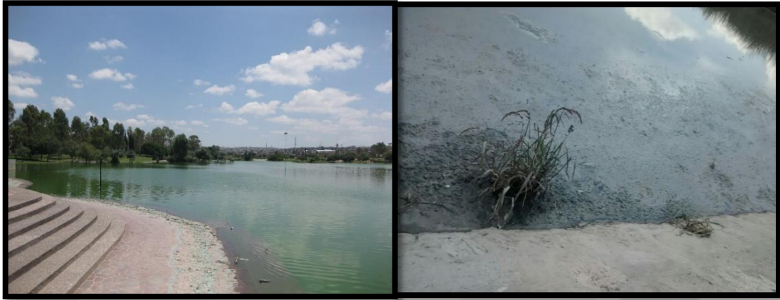
Fotografía 14. Presa de Los Gringos.
