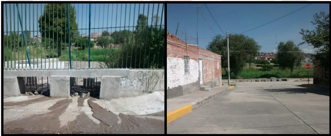
Fotografía 17. Calle Parque México, Fraccionamiento Progreso.
