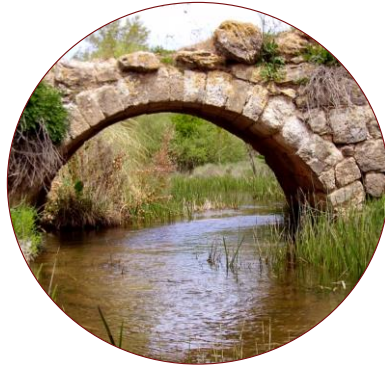
Figura 50. Puente de piedra al norte.
