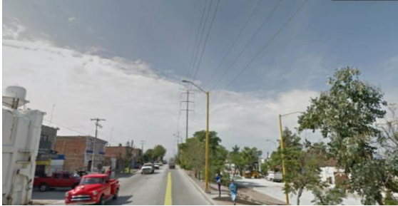
Fotografía 49. Líneas de tensión, 115kv.
