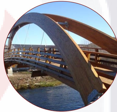
Figura 53. Puente de madera.
