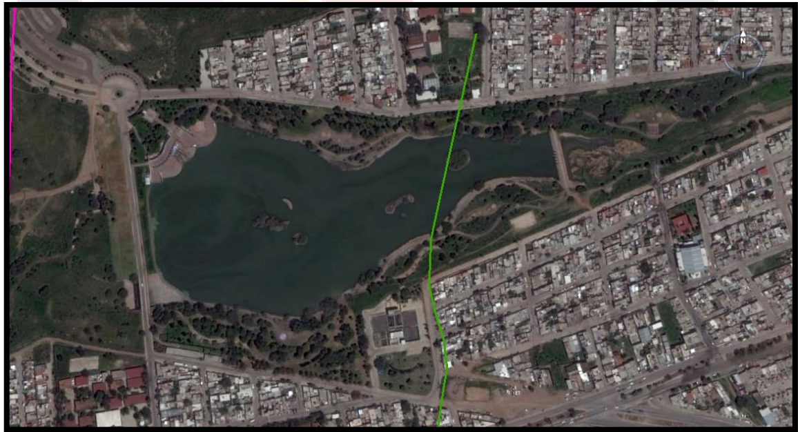
Figura 9. Falla Presa de Los Gringos.
