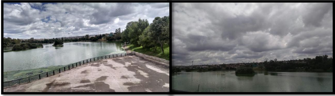
Fotografía 3. Presa de Los Gringos.
