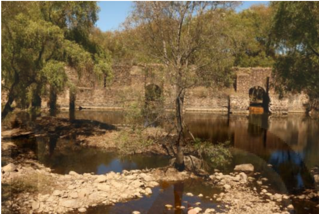
Foto 13.- Vista de obra civil sobre el Río Blanco.
