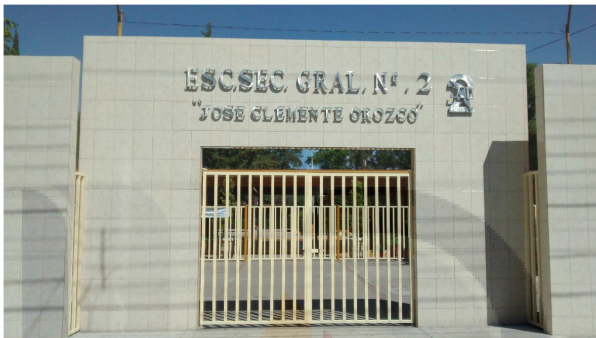
Foto 4. Secundaria como parte del equipamiento en la zona I.
