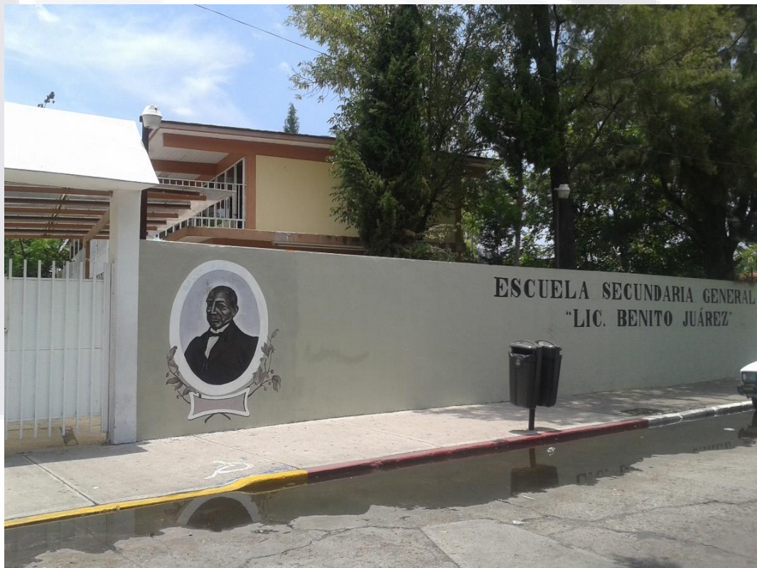
Fachada del edificio de la Escuela Secundaria General No. 1 “Lic. Benito Juárez”, con domicilio en la calle Pedro de Alba No. 357 en el barrio de San Marcos.
