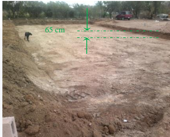
Figura 37 Cajón en Corte
