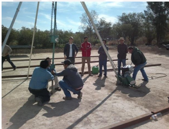
Figura 39 Prueba Penetración Estándar (SPT).
