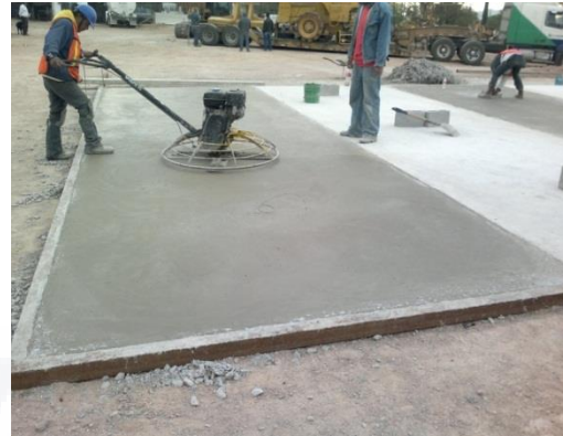
Figura 43 Construcción de Losas
