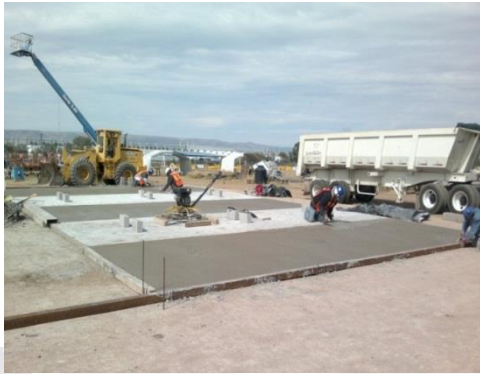
Figura 42 Acabado de Losas
