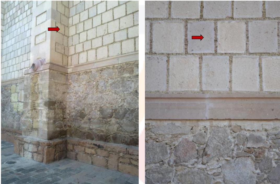
*Fig. 27 Muro principal de la nave hecho de mampostería con sillar de piedra.*
