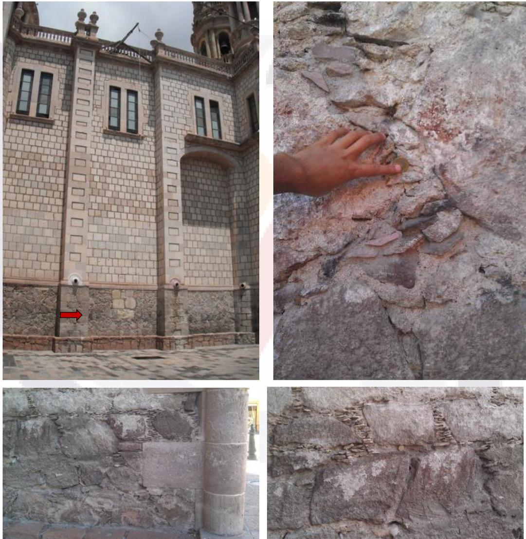
*Fig. 26 Muro de despegue construido de mampostería.*
