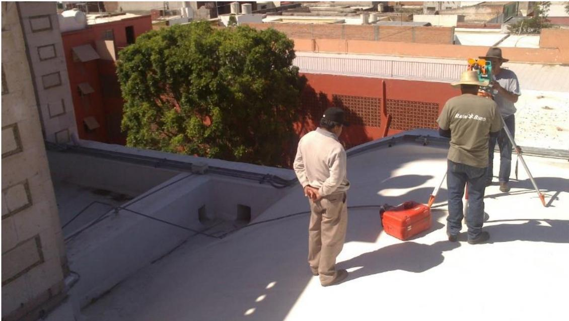
*Fig. 40 Levantamiento geométrico de bóvedas con estación total*
