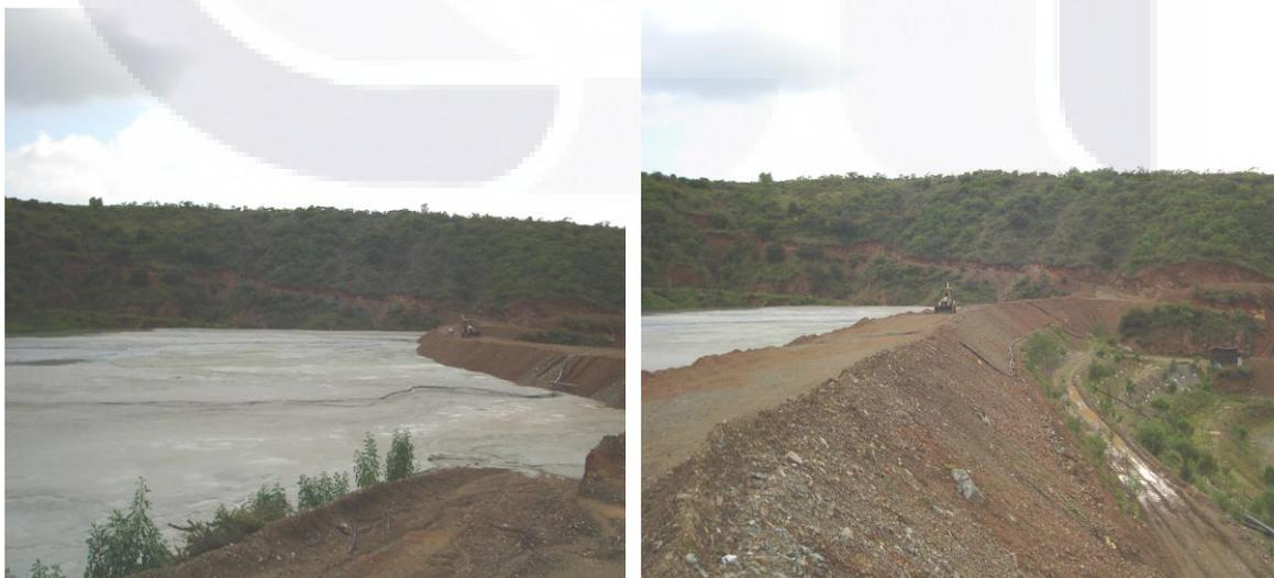
**Figura 8.** Cortina de la presa de jales de la mina Bolaños. Vaso de la presa de jales, actualmente se encuentra operando.
